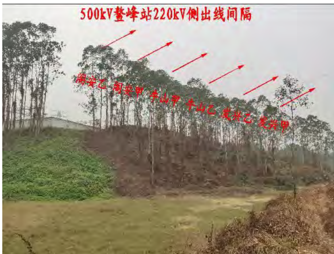
图 2-3 500kV 鳌峰变扩建 220kV 间隔侧现状
