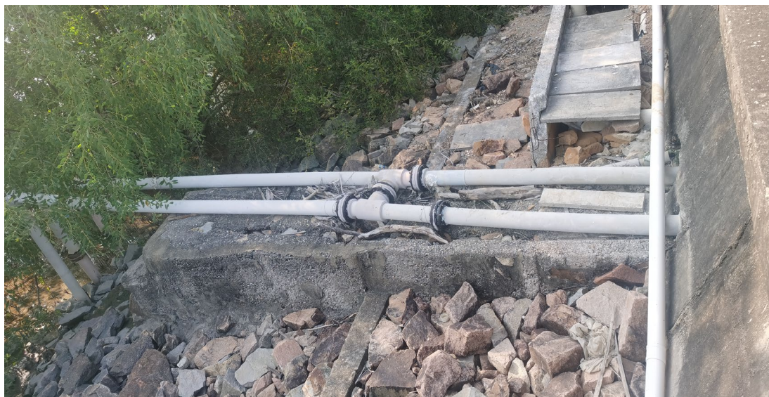
图 1-8 输水管线于堤岸处由地下埋设转为地表敷设
