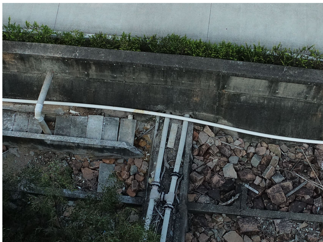
图 1-9 输水管线利用预制水泥涵管穿过堤岸及道路
