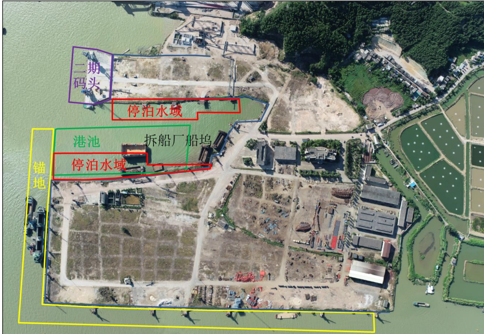
图 2.2-1 项目现状航拍图
