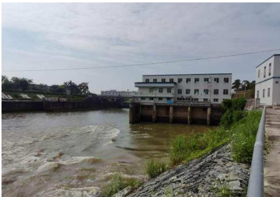
图 4.2.1-1 水闸、电站全貌
