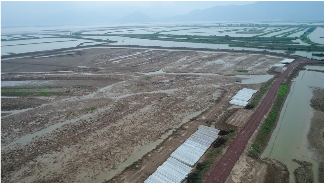
图 2.3.3-2 光伏区建设现状 2
