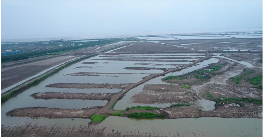
图 2.3.3-1 光伏区建设现状 1
