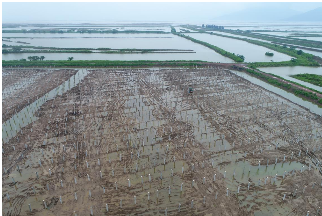
图 2.3.3-3 光伏区建设现状 3
