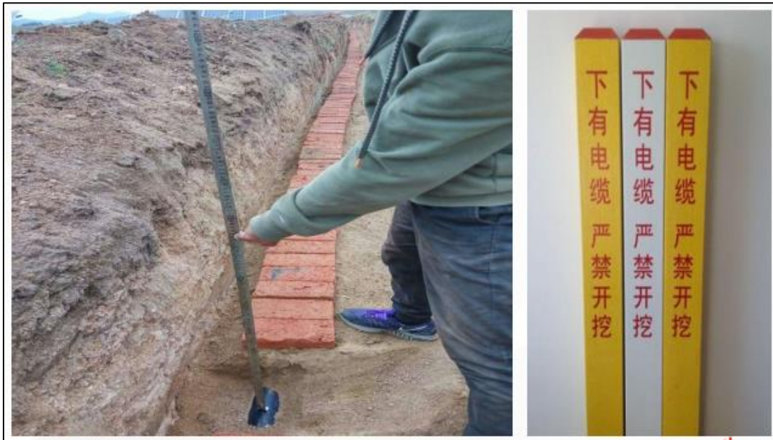
图 2.3.2-2 电缆敷设示意图
