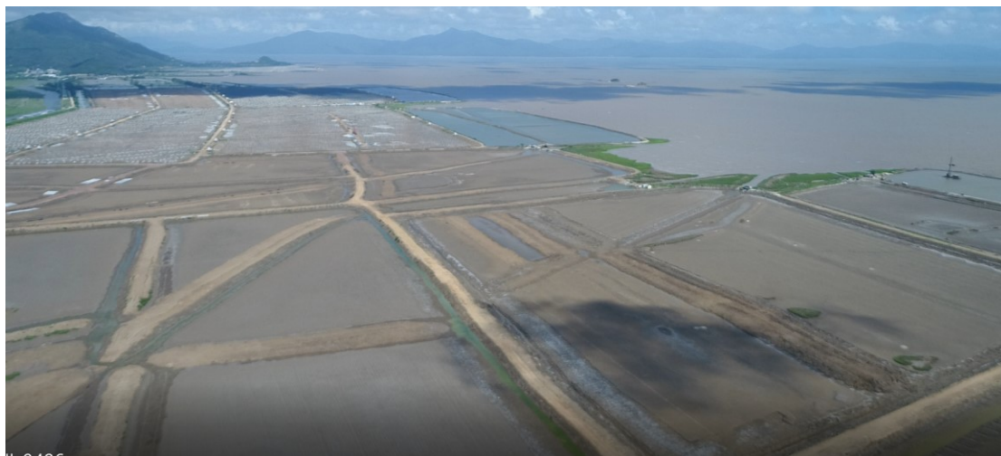
图 2.3.3-2 光伏区建设现状 2
