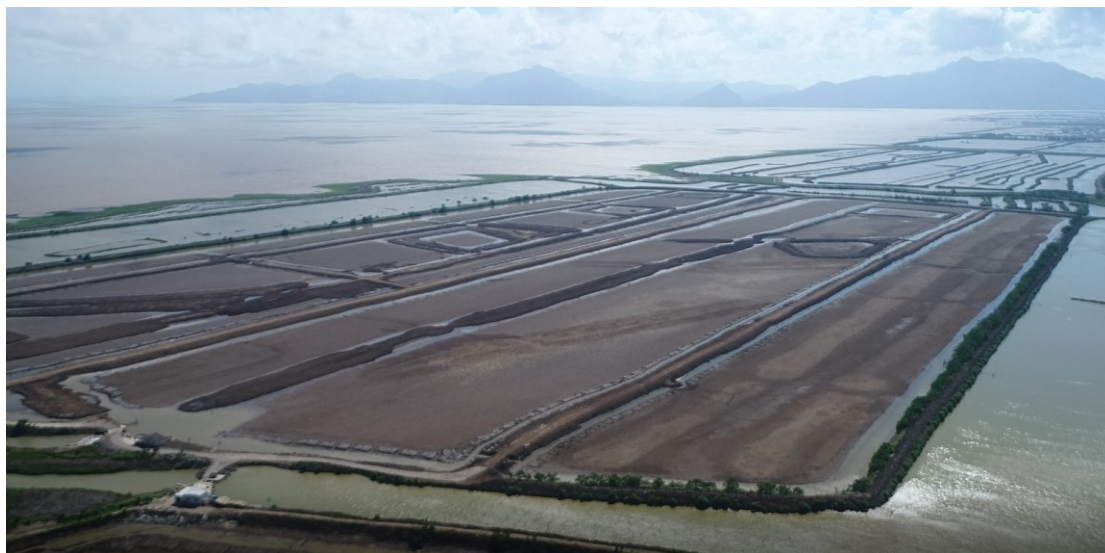
图 2.3.3-1 光伏区建设现状 1
