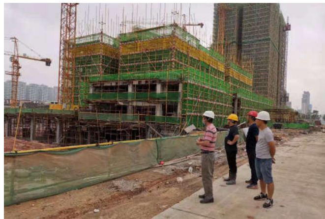
台山市住房城乡建设局检查“华浩明庭项目”
