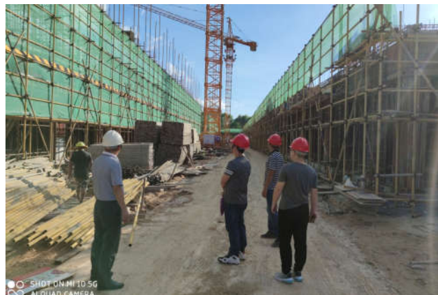
开平市住房城乡建设局检查“光正试验学校高中教学楼”
