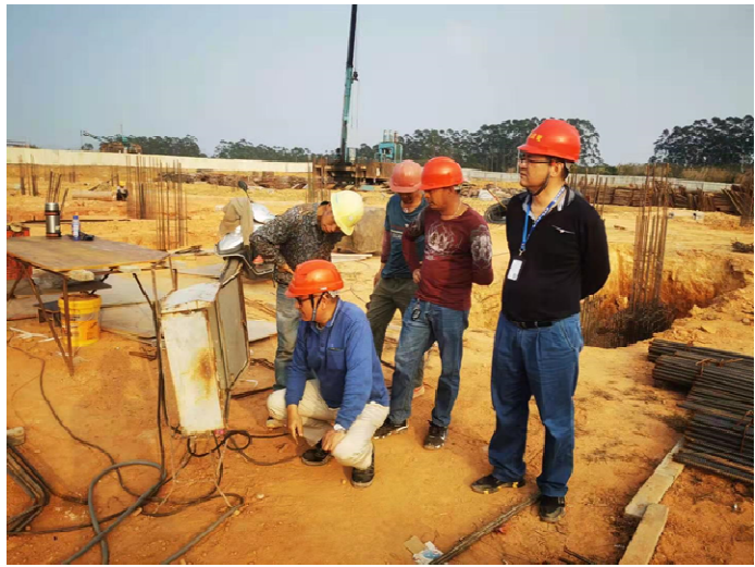
恩平市住建局检查“厂房一、厂房二、综合楼、门卫项目”
