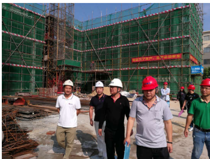
开平市住建局检查“侨园小学新建教学楼 1、2 项目”
