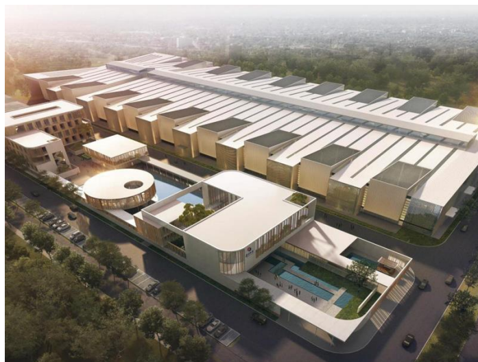
图3-6 广东建邦杭萧装配式有限公司
