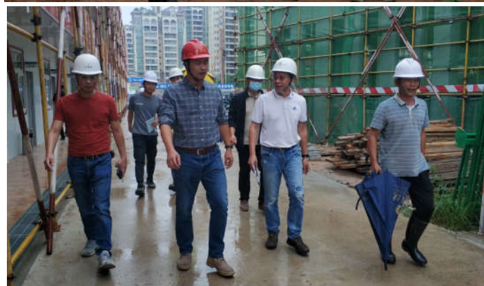
江门市住建局检查“江门市培英高级中学新校区建设工程项目”
