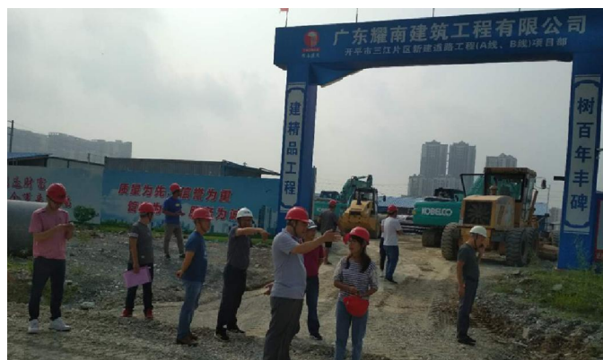
开平市住建局检查“开平市三江片区道路 A、B 线”项目
