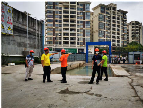
恩平市住建局检查“君汇上城（二期）”项目
