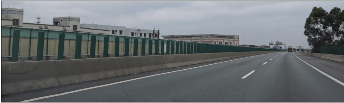
图4 现状中江、江鹤二期高速公路中央分隔带照片
