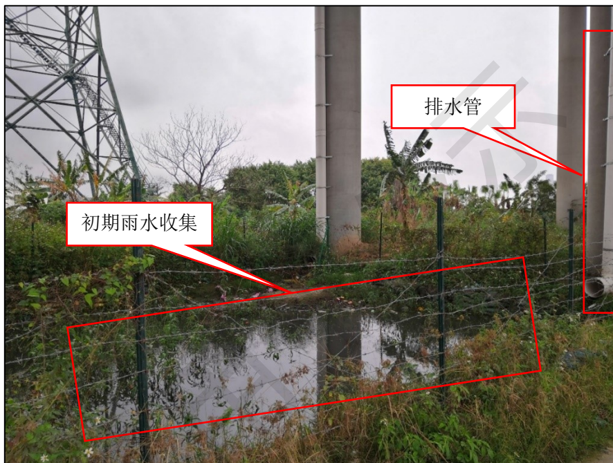
图 15 西江特大桥现状桥下排水管及污水收集池
