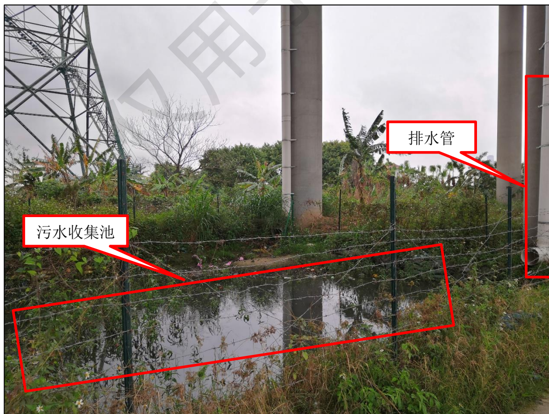
图 2.1-6 西江特大桥现状桥下排水管及污水收集池
