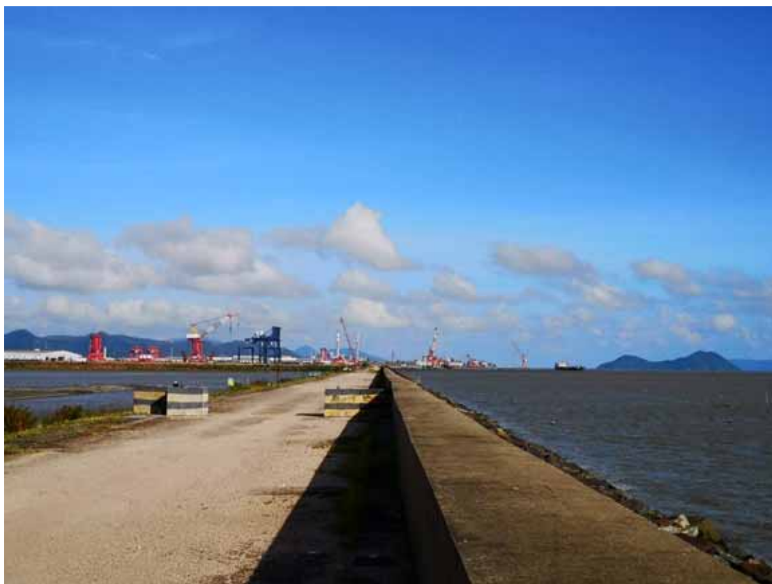
图 4.1.8-8 项目珠海段南侧现状（三一重工）
