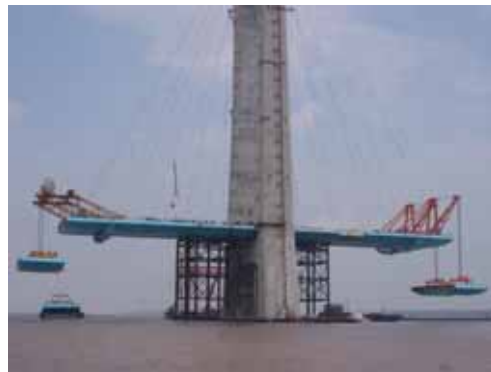
桥面吊机吊装标准段
