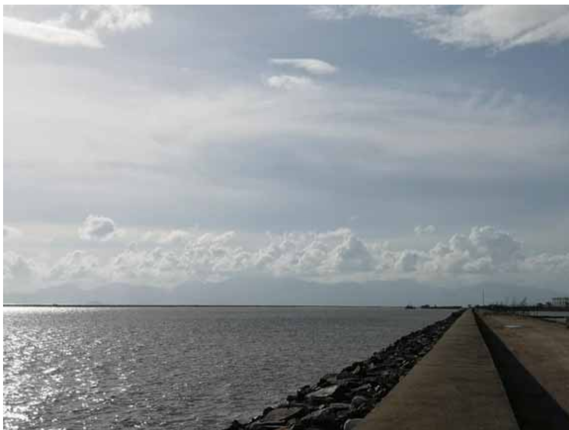
图 4.1.8-6 项目珠海段北侧现状（现状大堤）
