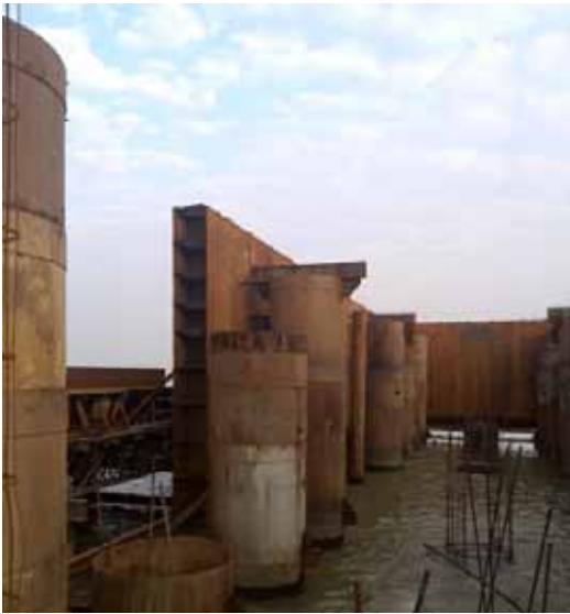
围堰分块加工，水上拼接
