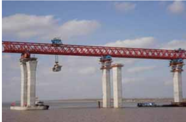
水上节段梁架设
