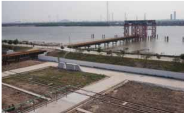
节段梁出梁码头
