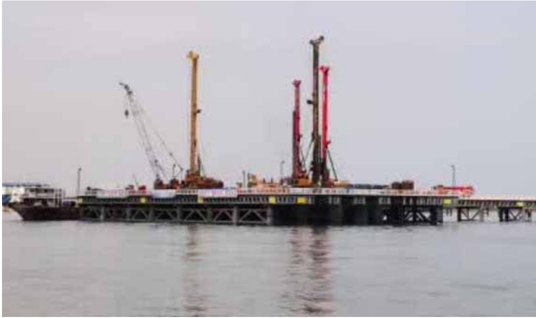
图 3.1.4-15 主墩施工平台例图
