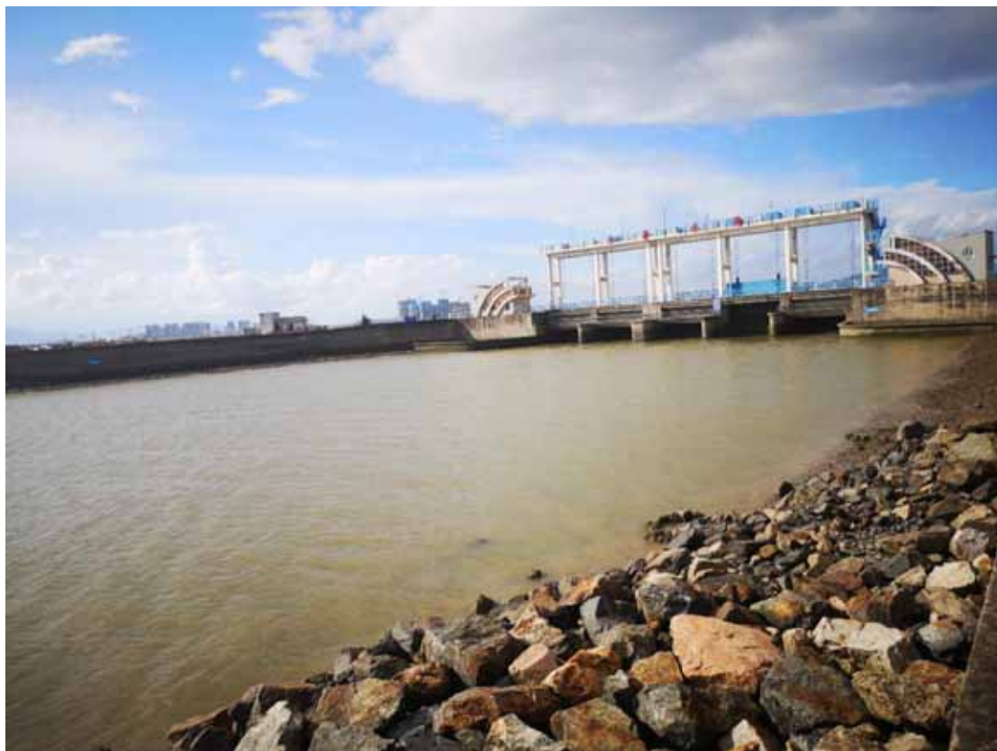
图 4.1.8-7 项目珠海段北侧三前水闸
