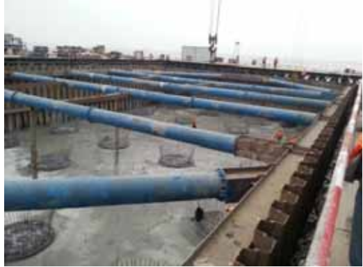
凿除桩头后进行承台施工
