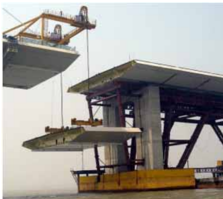
桥面吊机吊装标准段
