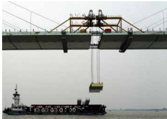
桥面吊机吊装标准段
