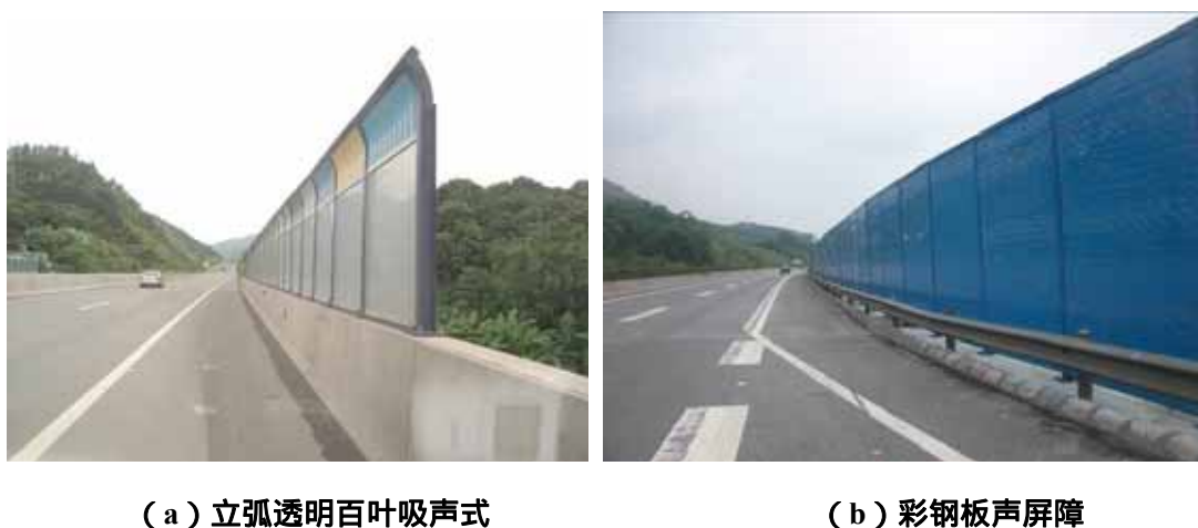
图 7.2.3-1 高速公路沿线常见声屏障
