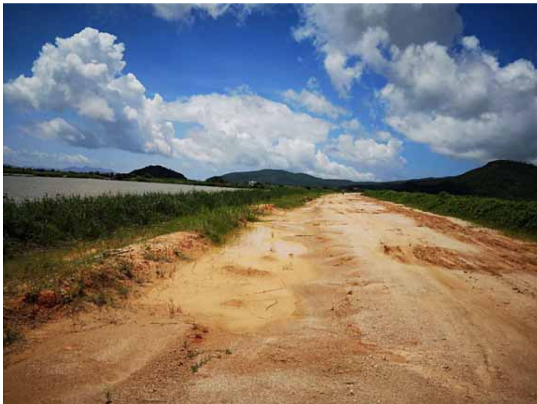
图 4.1.8-13 项目江门段北侧现状
