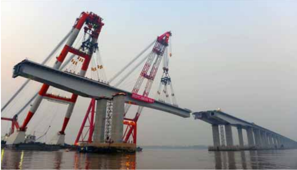
图 3.1.6-7 大节段钢箱梁吊装施工示意图
