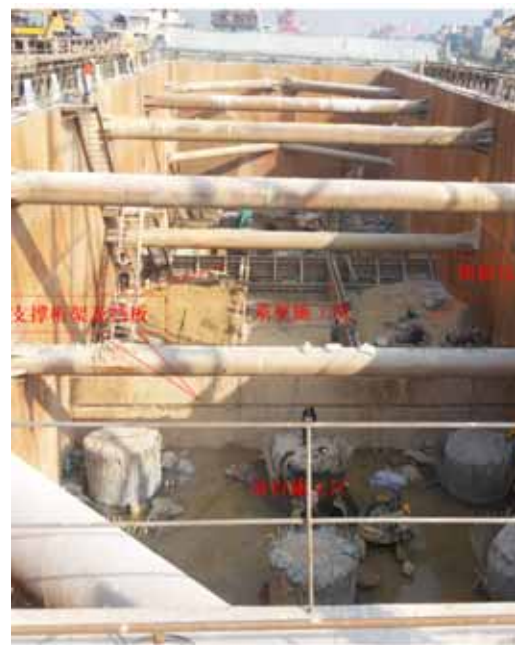
抽水完成、施工承台
