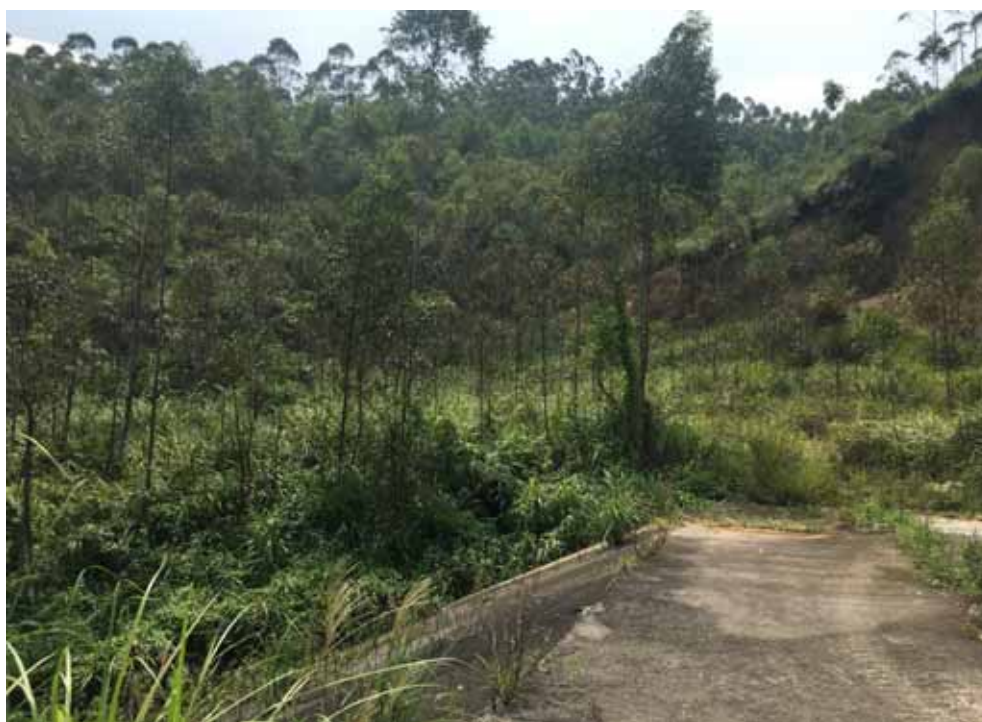
图 7.1.2-3 拦水坝现场照片
