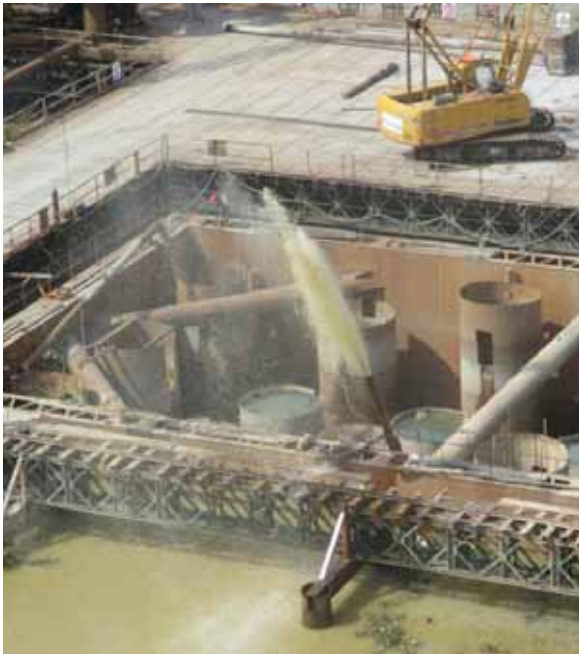
水下封底，回填压重砂、抽水
