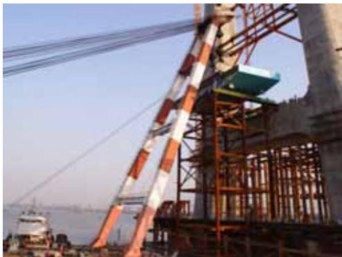
支架法浮吊吊装塔区梁段
