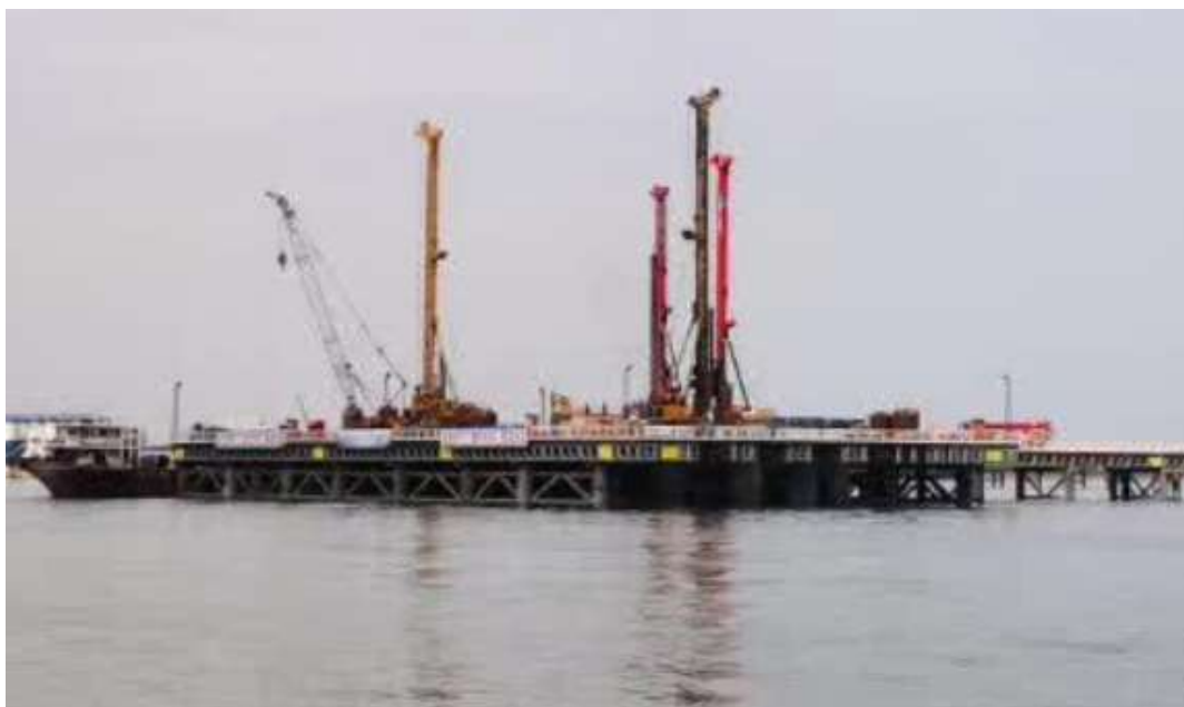
图 3.1.6-22 主墩施工平台例图
