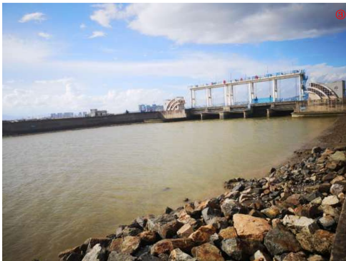
图 4.1.8-7 项目珠海段北侧三前水闸
