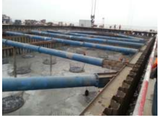
凿除桩头后进行承台施工
