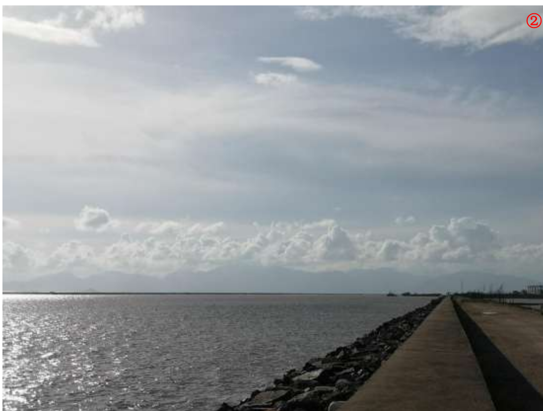
图 4.1.8-6 项目珠海段北侧现状（现状大堤）
