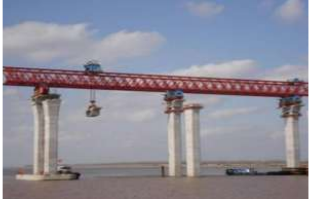
水上节段梁架设
