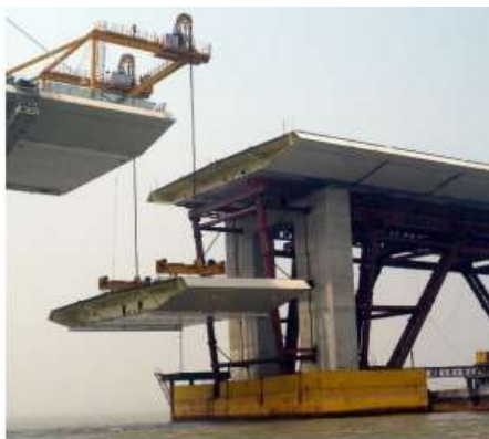
桥面吊机吊装标准段
