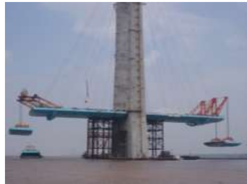
桥面吊机吊装标准段
