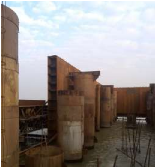
围堰分块加工，水上拼接
