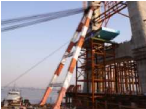
支架法浮吊吊装塔区梁段
