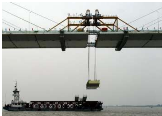
桥面吊机吊装标准段
