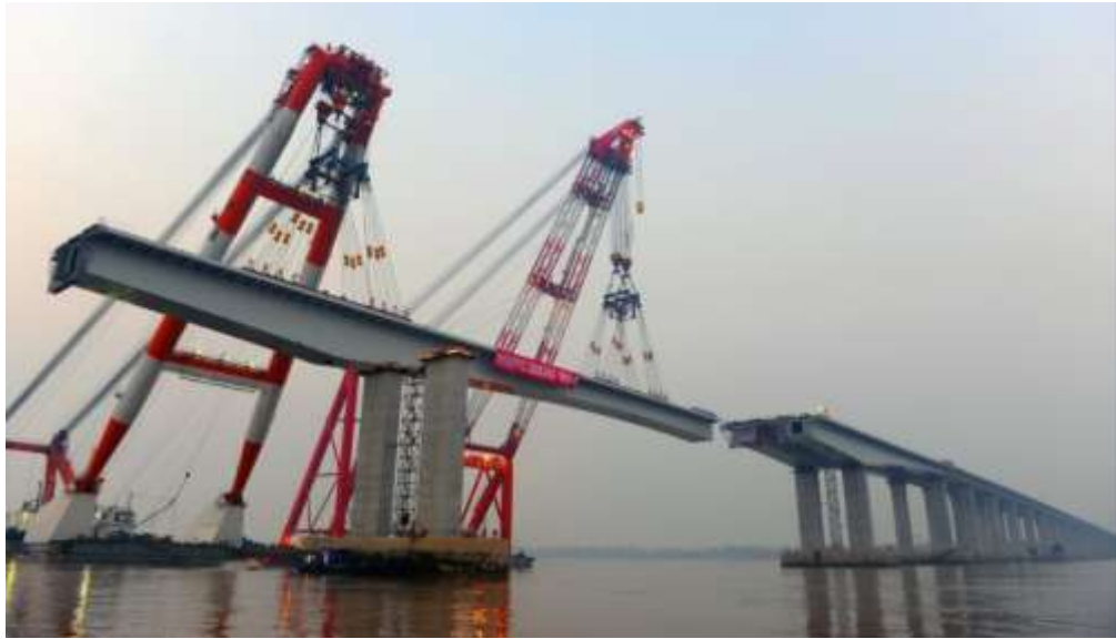
图 3.1.6-7 大节段钢箱梁吊装施工示意图
