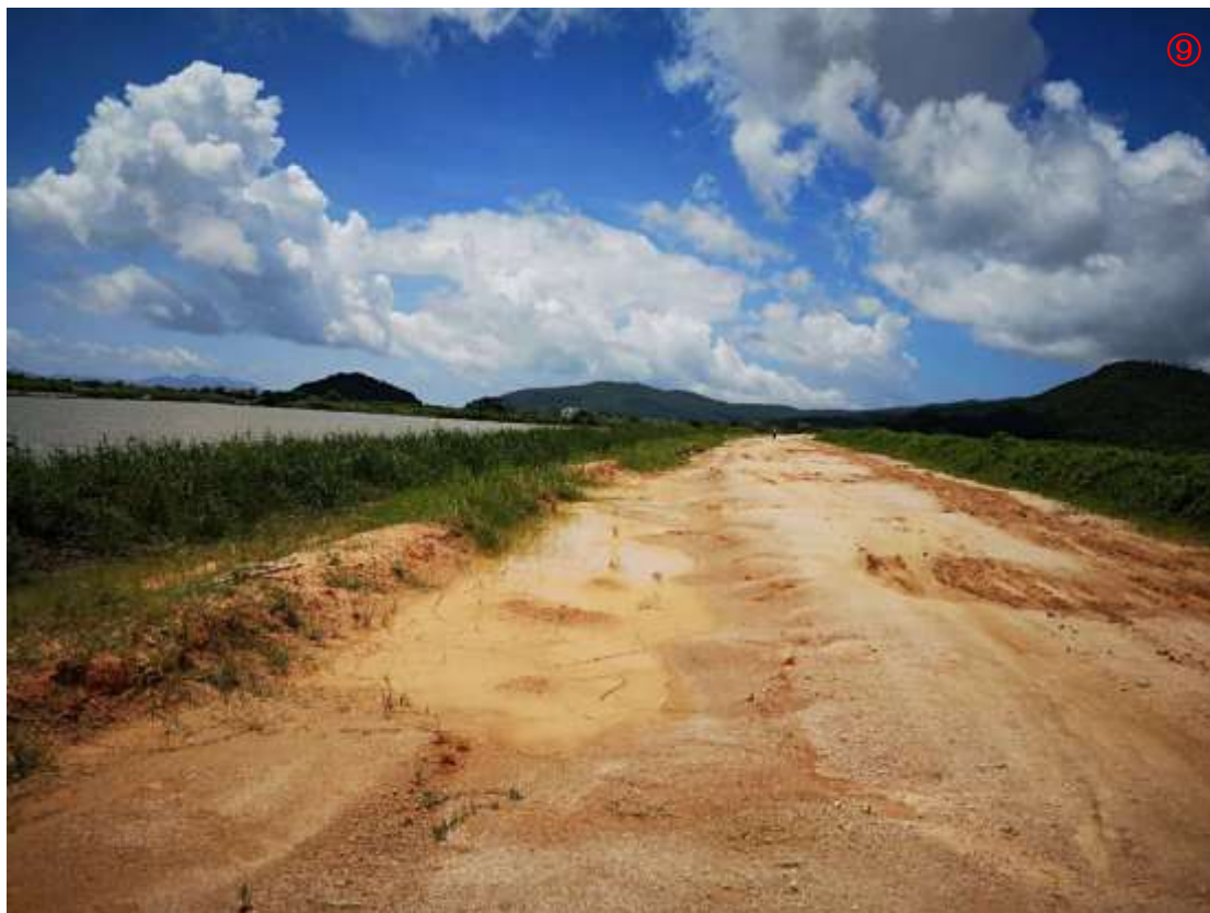
图 4.1.8-13 项目江门段北侧现状
