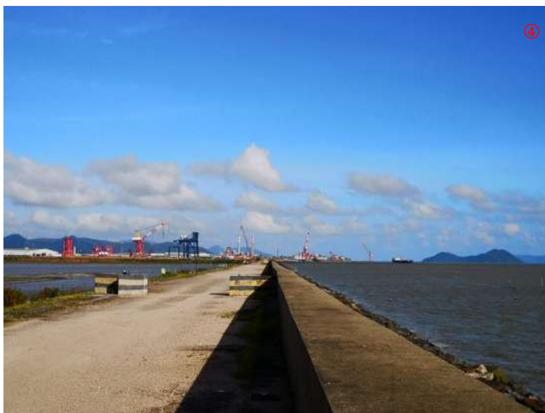
图 4.1.8-8 项目珠海段南侧现状（三一重工）
