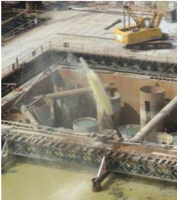
水下封底，回填压重砂、抽水
