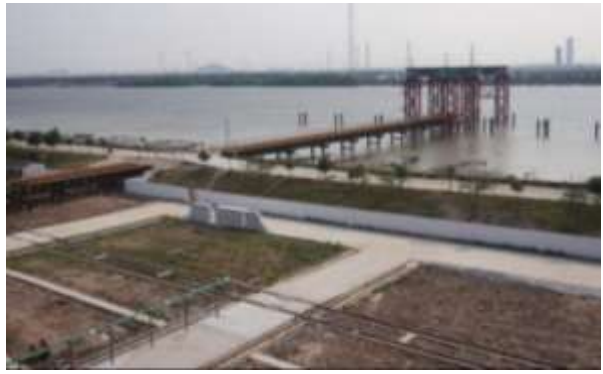
节段梁出梁码头
