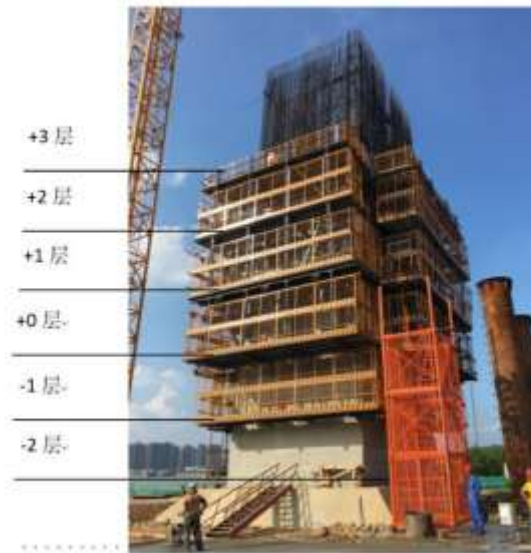
图 3.1.6-2 主塔施工示意图
