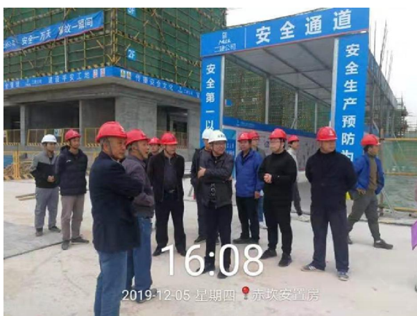
开平市住建局检查“开平赤坎古镇华侨文化展示项目安置房项目”
