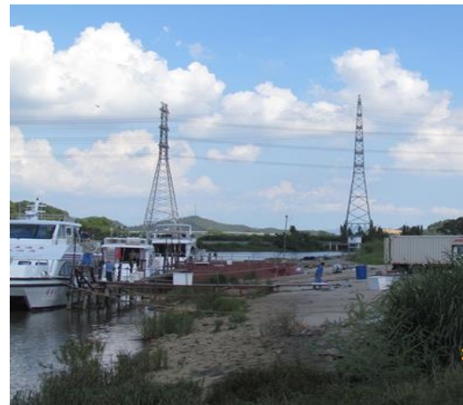
现状峰外甲乙#13-#14 塔跨越虎坑河
