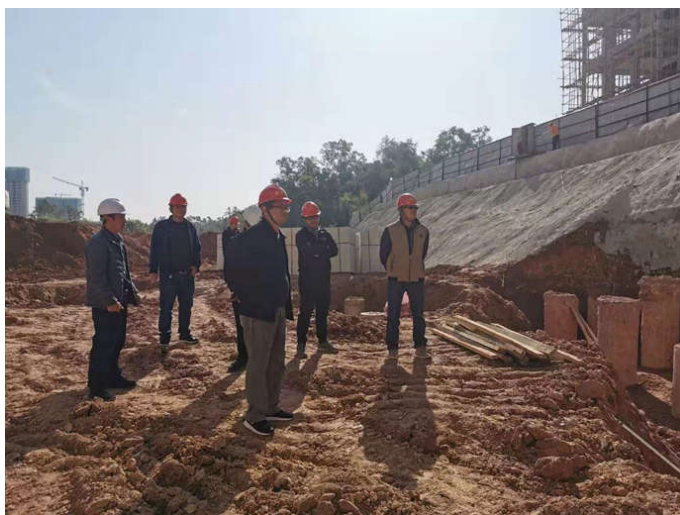
恩平市住建局检查“君汇上城（二期商住楼）”项目
