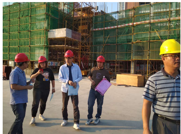
开平市住建局检查“开平市职业教育公共实训中心（吴汉良理工翠山湖校区）项目（二期）”项目
