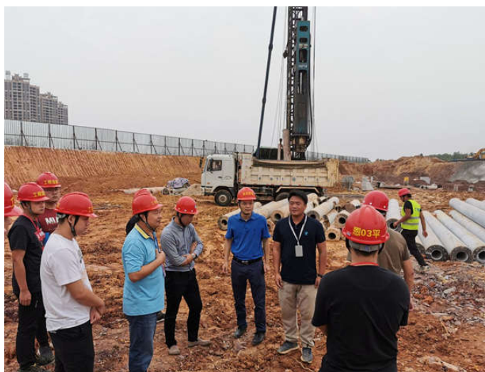
恩平市住建局检查锦江帝景花园（一期）商业二
