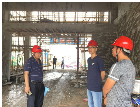
开平市住建局检查开平市翠山湖实验学校配套工程
