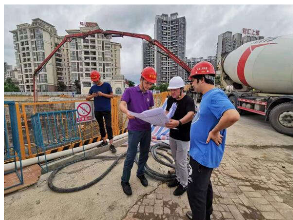
恩平市住建局检查恩平锦绣香江花园二期项目
