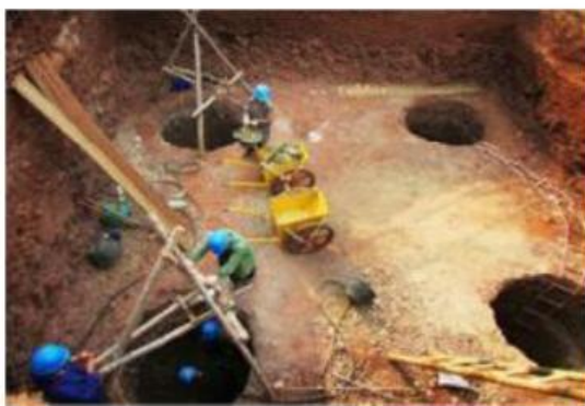
照片 5：塔基基础施工
