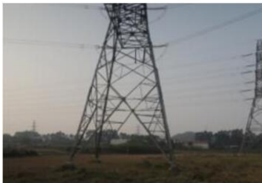
照片 8：塔基绿化
