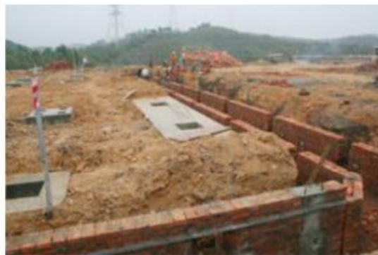
照片 4：新建站址区施工
