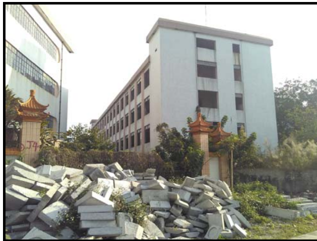
宁华电力公司 5层闲置仓库楼房
