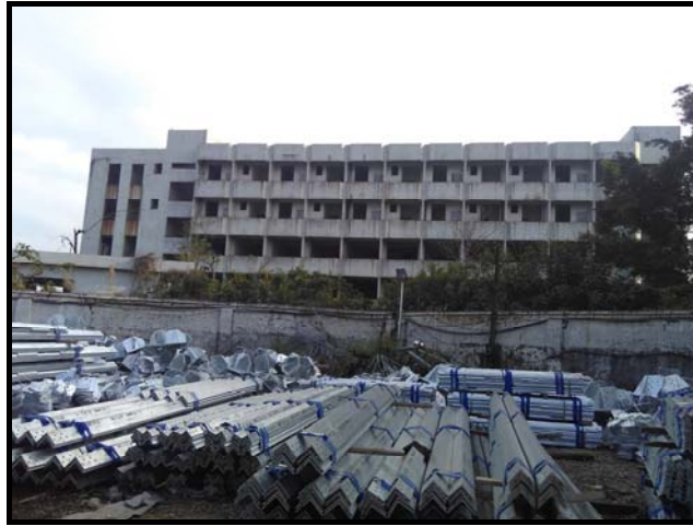
广东乐华空调器有限公司 4层空置厂房
