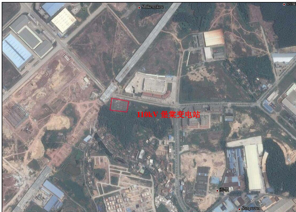
图 1 110kV 堡棠变电站现状 Google 照片
