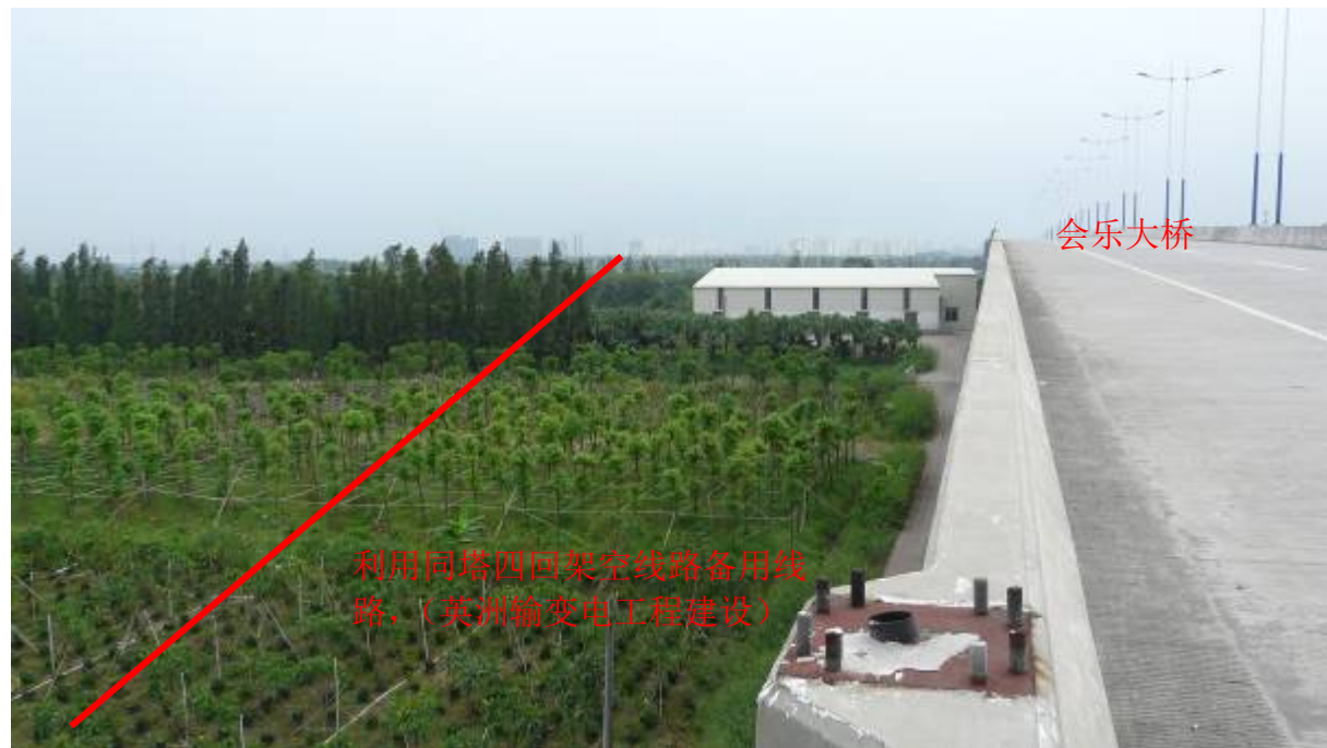
图 8 江门水道东侧 110kV 架空线路走向
