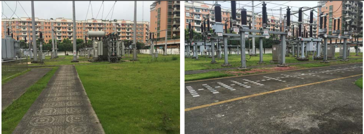
图3 东区变电站站址现状照片
