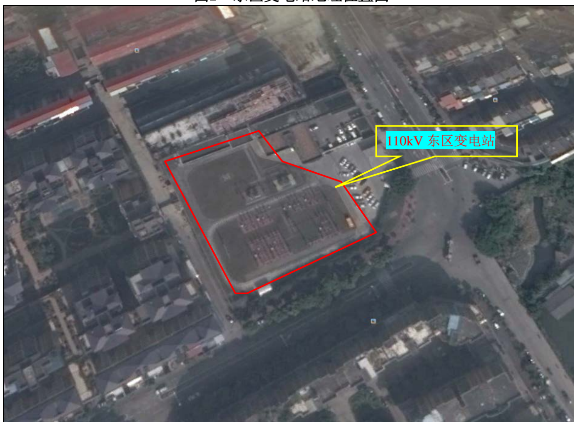
图2 东区变电站站址卫星图片
