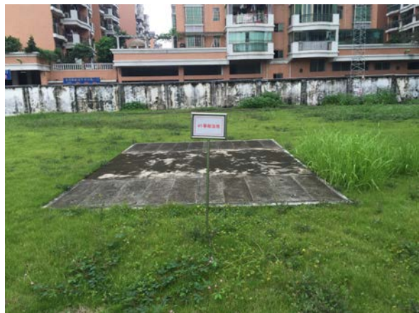
图 15 站内事故油池
